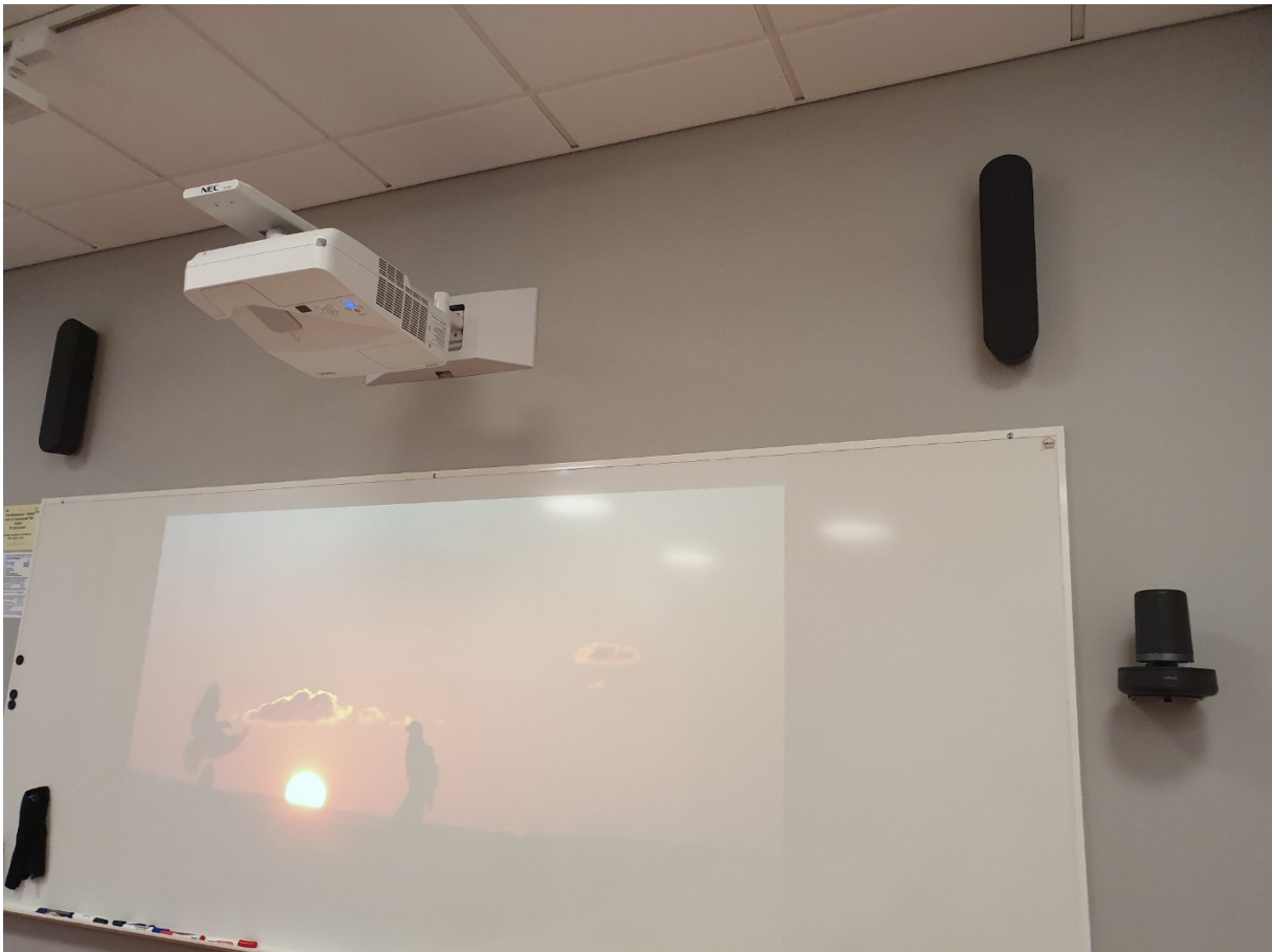
Rallysystemet monterat på vägg, här syns högtalarna samt kameran
